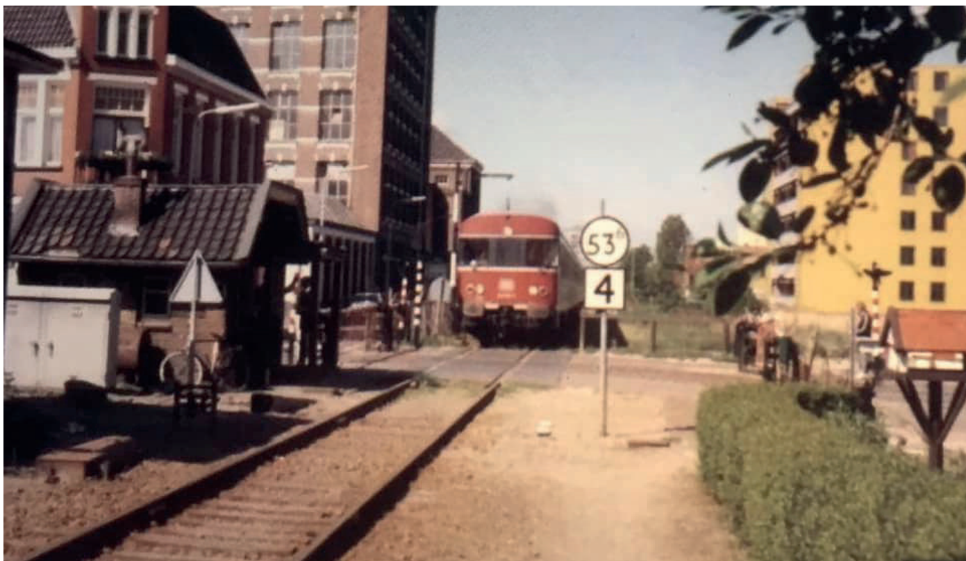
Spoorwegovergang Oldenzaalsestraat-Parallelweg omstreeks 1980. Vanuit het huisje aan de linkerkant werden de slagbomen bediend door de medewerker van de spoorwegen die naast het spoor, aan de rechterkant woonde.
